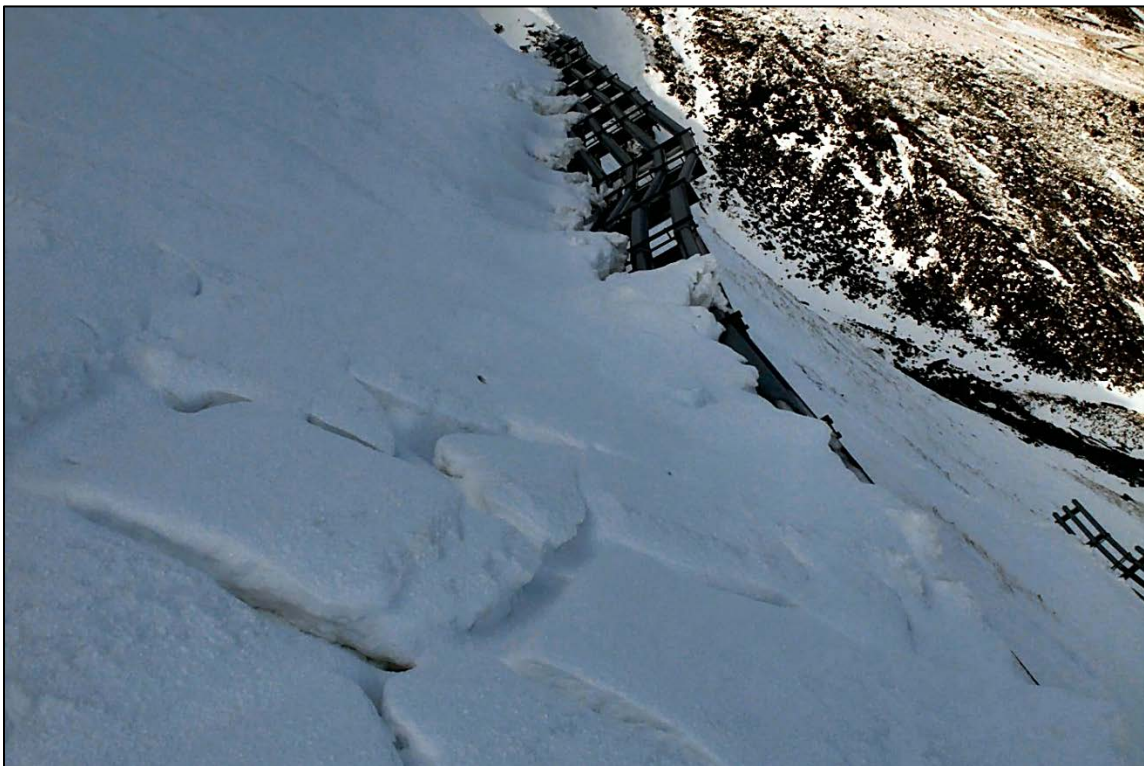
Mynd 13. Varnarvirkin ofan Heilsugæslunnar. Hér sést vel hvernig snjórinn hefur hrannast upp á grindurnar.
