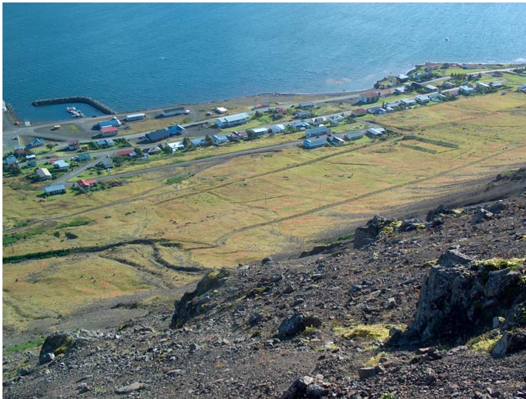
Mynd 2: Innri varnarskurðurinn ofan við byggðina á Þingeyri. Á myndinni sést einnig hluti ytra varnarskurðsins og staðurinn þar sem skurðirnir tengjast (Ljósmynd: Þorsteinn Sæmundsson 2003).
