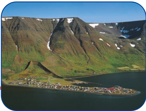
Flateyri. Snjóflóðavarnarvirkin veita öryggi gagnvart snjóflóðum úr Skollahviltf og Bæjargili.
