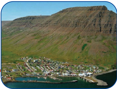
Bolungarvík. Unnið var að undirbúningi varnarframkvæmda á árinu.
