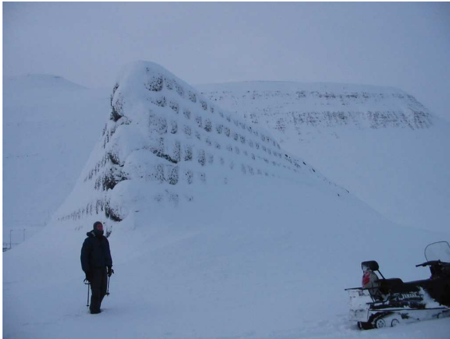
Mynd 11: Stefni varnarfleygsins ofan Funa og tunga snjóflóðsins sem féll 3. janúar þar sem hún liggur upp að varnargarðinum (ljósmynd: Oddur Pétursson, 4. janúar 2005).
