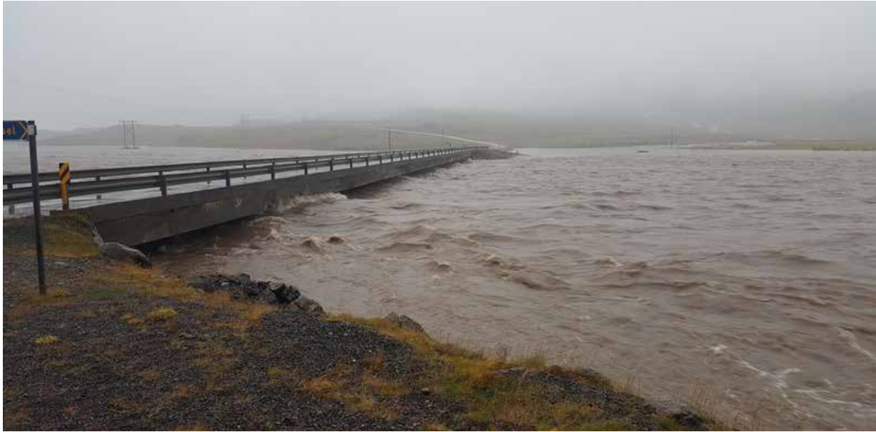
Mynd 1.2 Miklar skemmdir urðu á vegum í vatnsveðri sem gekk yfir Suðaustur- og Austurland síðustu dagana í september 2017. Flóð ollu vandræðum, m.a. í Suðursveit, Álftafirði, Hamarsfirði, Berufirði og í Fljótsdal. Brúin yfir Steinavötn skemmdist og vatn náði upp að gólfi brúarinnar yfir Hamarsá. Myndin, sem tekin er 27. september 2017, sýnir flóðið í Hamarsá í Hamarsdal. Ef úrkomuákefð eykst geta atburðir sem þessir orðið algengari. (Ljósmynd: Ragnar Eiddsson.)
