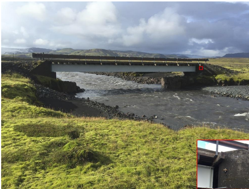
Mynd 5 Myndir af Vatnshæðarmæli (kafara, efri myndir) og staðsetningu loftþrýstingsmæli á brú (neðri mynd).
