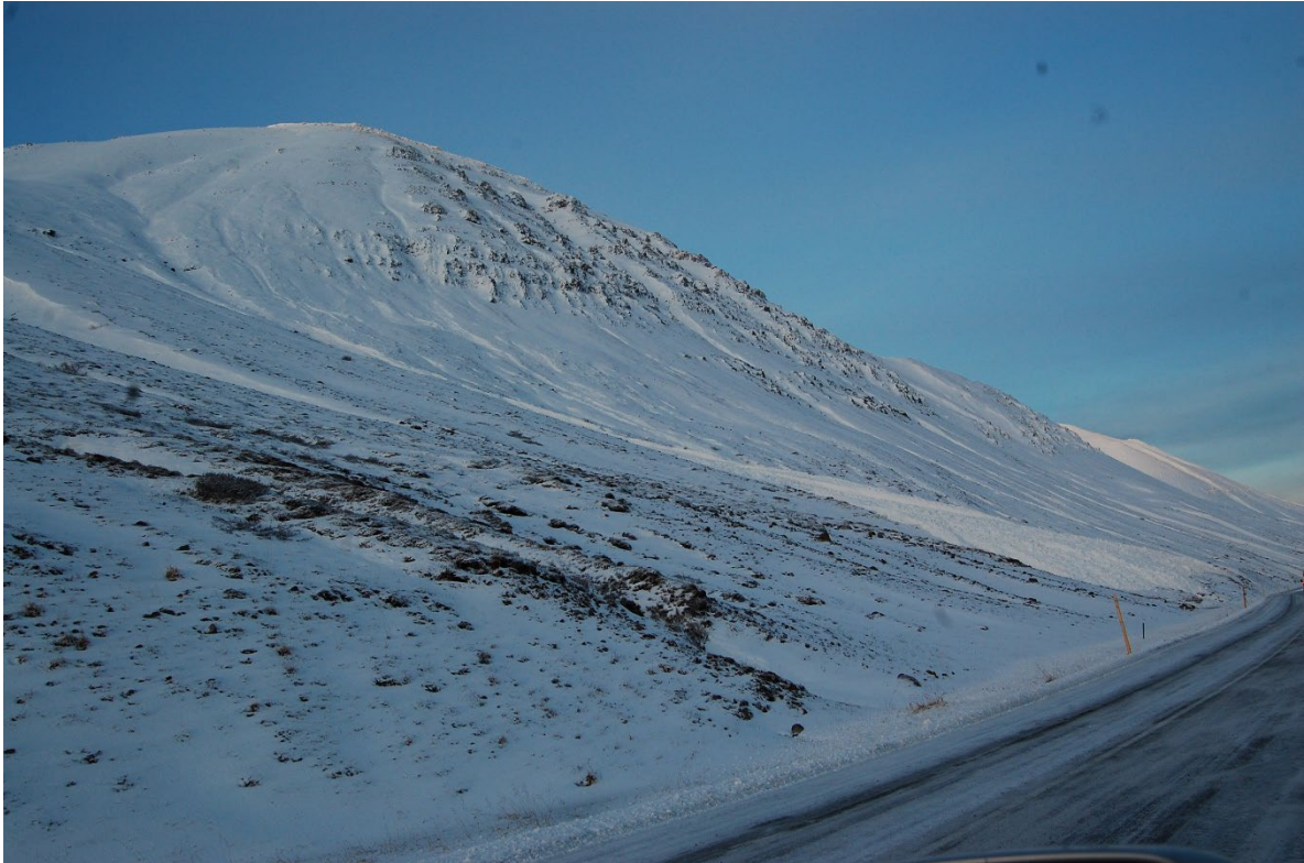
Mynd 3. Snjóflóð ofan Ólafsfjarðarvegjar 21. nóvember.
