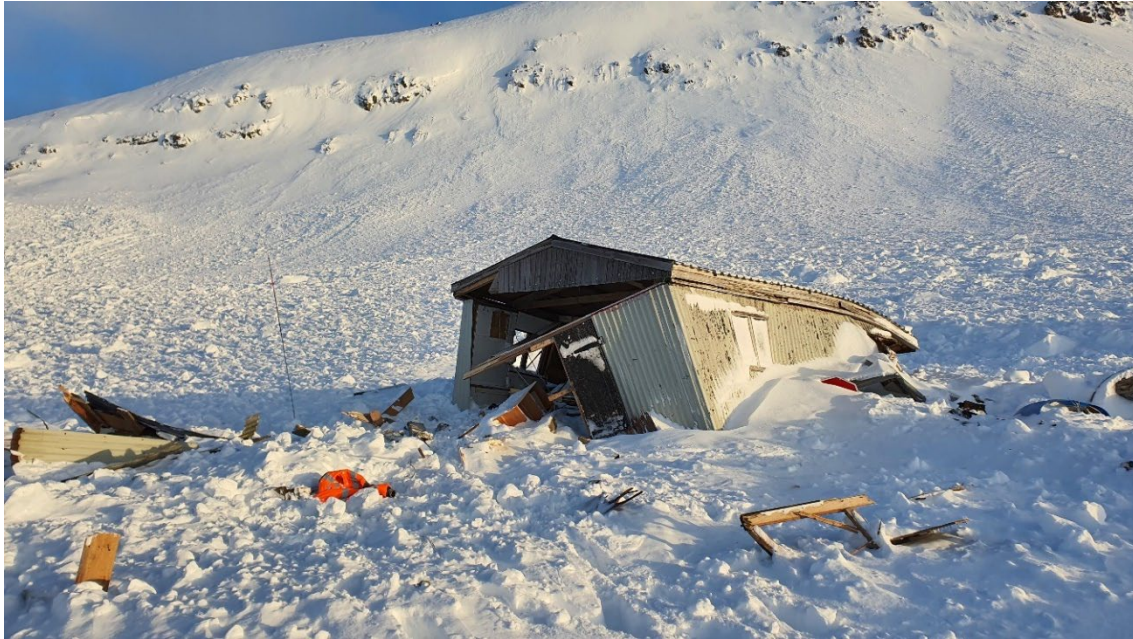
Mynd 31. Aðstöðuhúsið á skotsvæðinu tjónað eftir flóðið.
