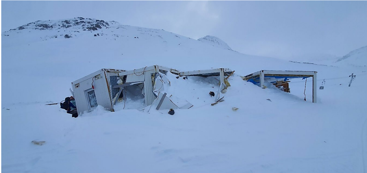
Mynd 5. Snjóflóðið í Skarðsdal eyðilagði skíðaskála, gáma og tæki. Ljósmynd: Sigurður Þór Helgason.
