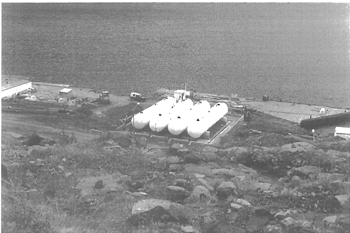
Mynd 36. Nýir olútankar sem verið er að byggja fyrir neðan Hörmungarlæk (farveg 11) (Ljósmynd Halldór G. Pétursson 1997).
