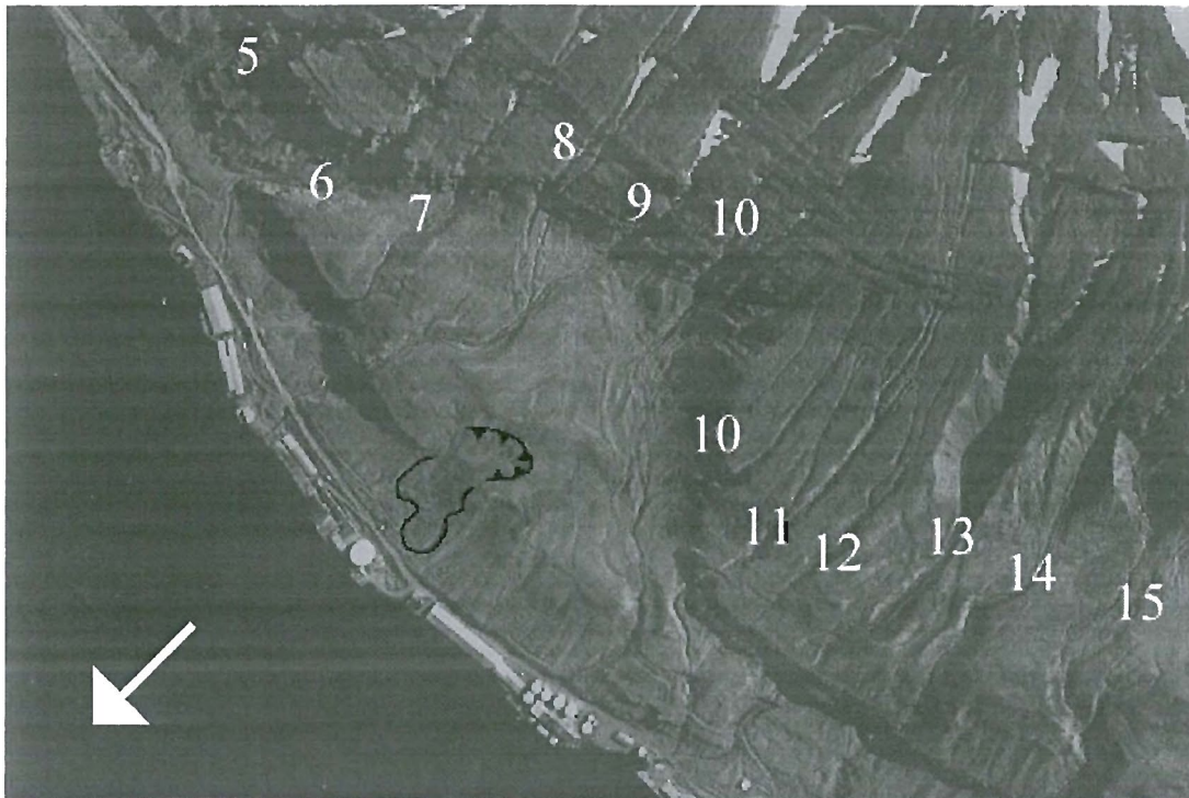
Mynd 27. Þófi og Þófabrún. Farvegirnir sem falla um Þófa eru vel greinanlegir á þessari mynd. Auk þess má greina skriðuör í Þófabrúninni rétt innan við Þófalæk. Tölustafir tákna númer farvega (Landmælingar Íslands, loftmynd 0434, 1994).
