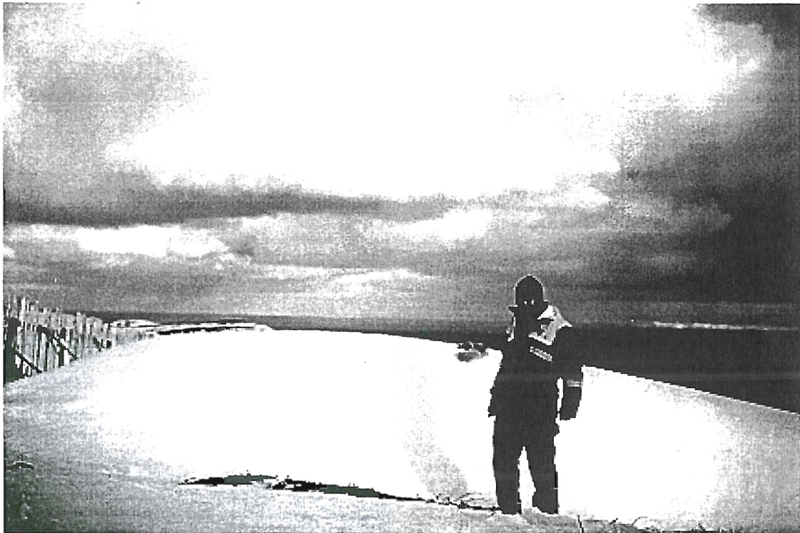
Mynd 16 Skaffinn er um 1,5 m hlémegin við grindaröð B. Grindur höfðu brotnað í miðri röð og þar sést í jörðu (Ljósmynd: Sigurður Kiernan 3. nóvember 1998).
