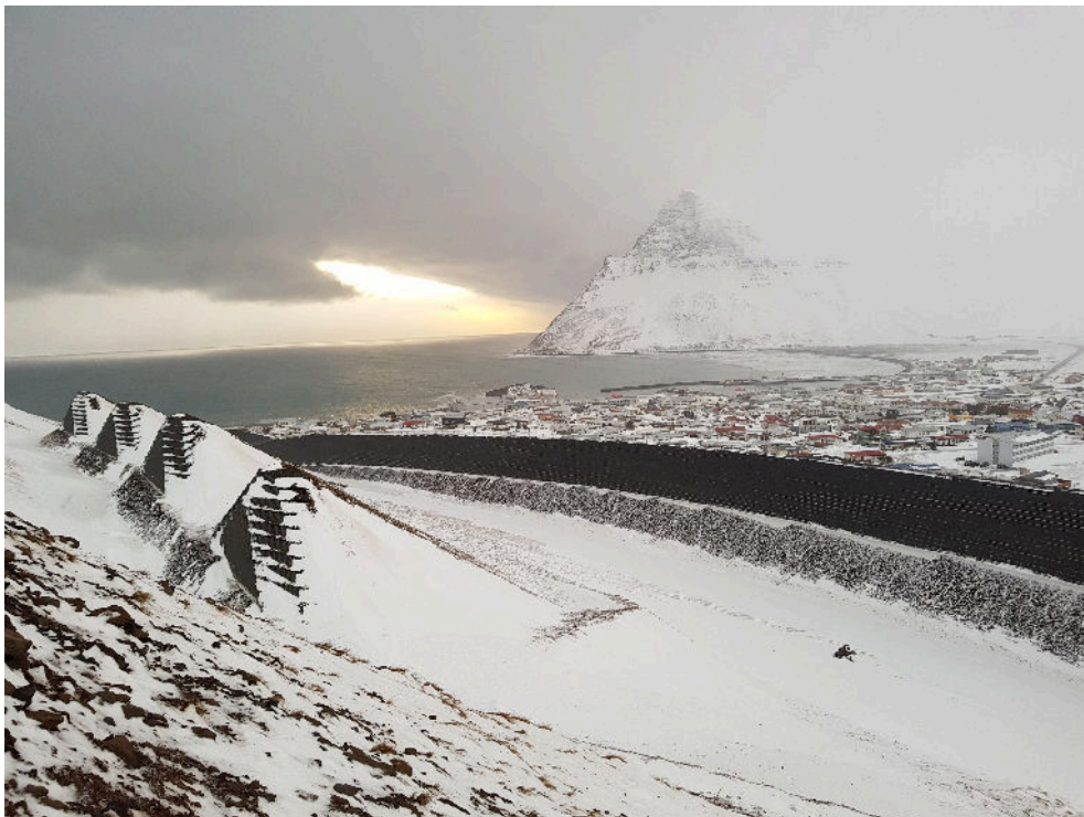
Mynd 1. Stærri varnargarðurinn undir Traðarhyrnu við Bolungarvík nefnist Vörður og er 22 m hár þar sem hann er hæstur. Hliðin sem snýr upp í fjallið er brött. Keilur ofar í hliðinni eru 12 m háar og snúa brattri hlið á móti flóðstefnunni. Þeim er ætlað að hægja á snjóflóðum áður en þau lenda á varnargarðinum. Ljós.: Jóhann Hannibals-son, 15. febrúar 2020.
