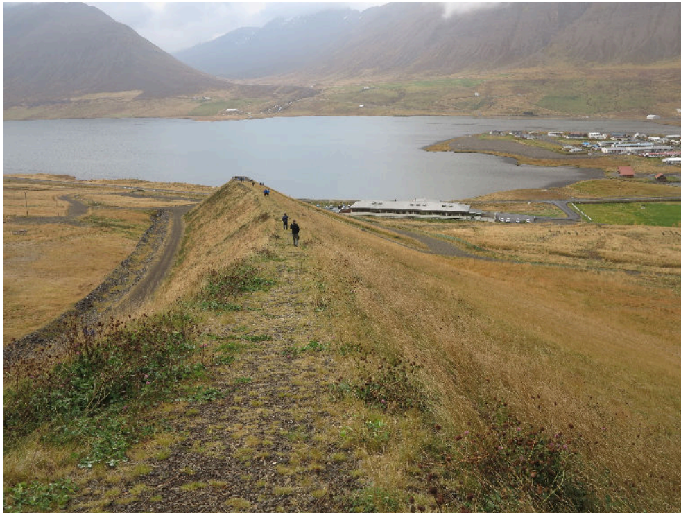
Mynd 6. Horft niður eftir leiðigarði við Hornbrekku. Sjá má að flóðmegin er garðurinn brattur, eftir því sem unnt er fyrir garð sem hlaðinn er úr lausum jarðefnum, en að norðanverðu er garðurinn meira aflíðandi til þess að falla betur inn í umhverfið. Myndin sýnir vel sveigju á stefnu garðsins sem veldur því að leiðihornið hækkar niður með honum. Ljós.: Tómas Jóhannesson, 8. október 2014.
