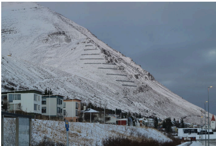
Mynd 5. Stoðvirki í Gróuskarðshnjúki sem reist voru árið 2004. Ljós.: Tómas Jóhannesson, 11. desember 2022.
