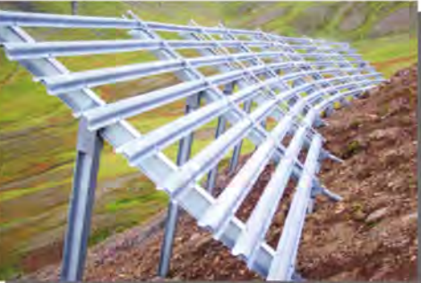
Uptakastoðvirkin minnka líkur á að snjóflóð fari af stað. Steel bridges reduce the risk that avalanches are released. (MYND Þ.J.)
