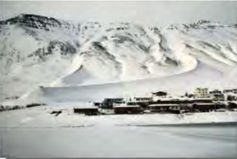
Leiðgarðarnir beina snjóflóðum frá byggð. Deflecting dams direct avalanches away from the village. (MYND S.K.)
