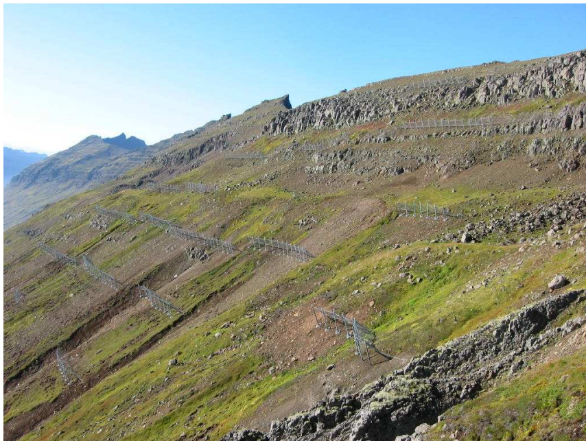
Mynd 2: Snjóflóðanet í Drangagili í Neskaupstað sem sett voru upp 2001–2002. Ljósmynd: Tómas Jóhannesson 12. september 2002.
