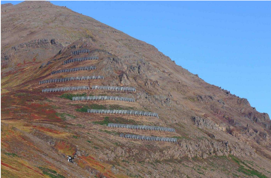
Mynd 1: Stálgrindur í Gróuskarðshnjúki á Siglufirði sem settar voru upp sumarið 2004. Frágangi sneiðinga sem notaðir voru við uppsetningu grindanna var ekki að fullu lokið þegar myndin var tekin. Ljósmynd: Júlíus Hraunberg 28. september 2004.
