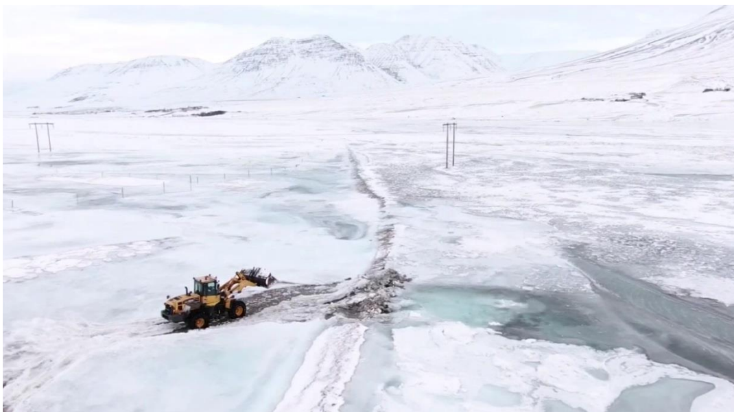
Mynd 36. Lagfæring á varnargarð við Stokkhólma (mynd: Páll Friðriksson, 2021).
