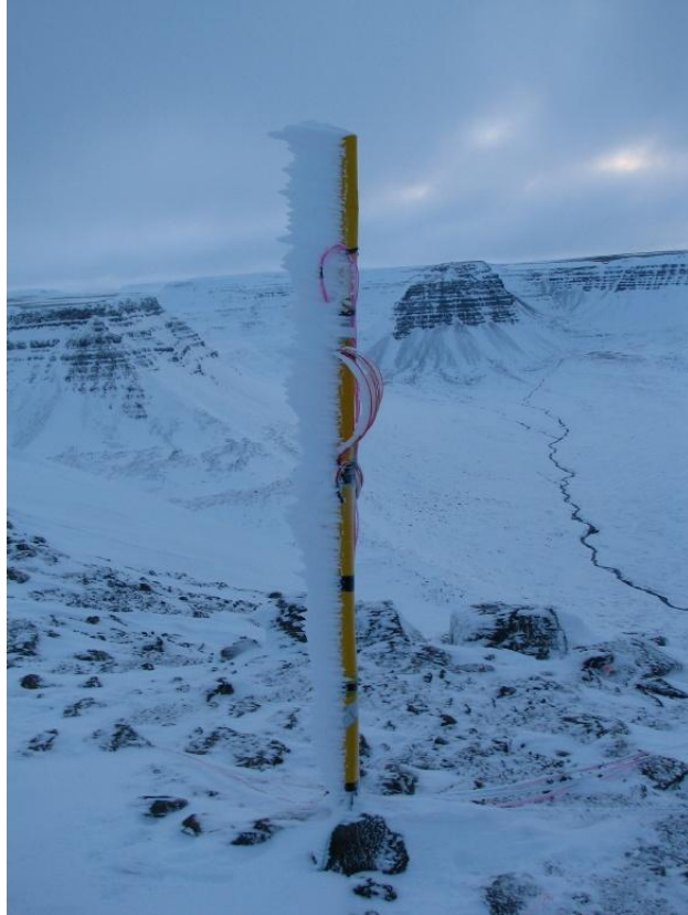
Mynd 1. Stika á skotstað með non-el framlengingarsnúrum sem tengdar eru við hvellhettur. Myndin er tekin við dæmigerðar ísingaraðstæður.
