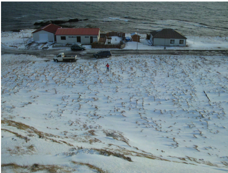
Mynd 12. Svæðið ofan Grundargötu. Fyrir um 30 árum felldi snjóflóð fjárhús sem stóðu ofan vegarins og má sjá undirstöður þess til hægri á myndinni. Maðurinn á myndinni stendur nærri þeim stað þar sem snjóflóð stöðvaðist fyrir um 20 árum. Ljósmynd: Veðurstofan, febr. 2008.
