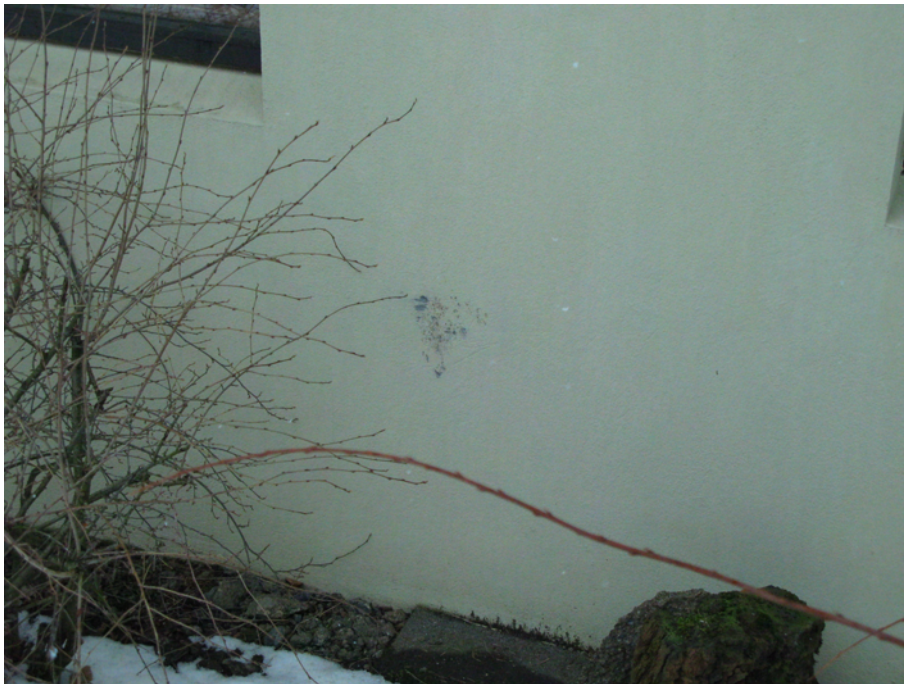
Mynd 6. Far eftir grjóthrun á útvegg hússins að Skerjavöllum 10. Ljósmynd: Veðurstofan, mars 2008.
