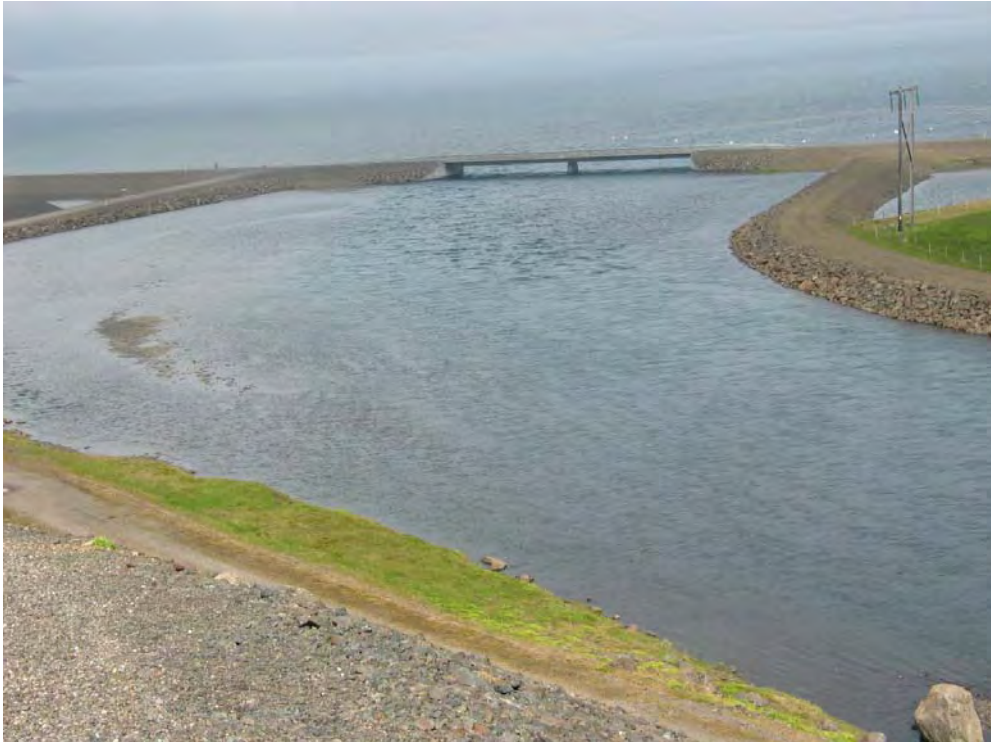
Mynd 9. Ós Fossár á flóði. Rennslismælingarnar fara fram nærri ósnum. Varast ber bakvatnsáhrif frá sjávarföllum sem geta haft áhrif á vatnsmagnið sem fer í gegn um mælisniðið á meðan mæling stendur yfir.
