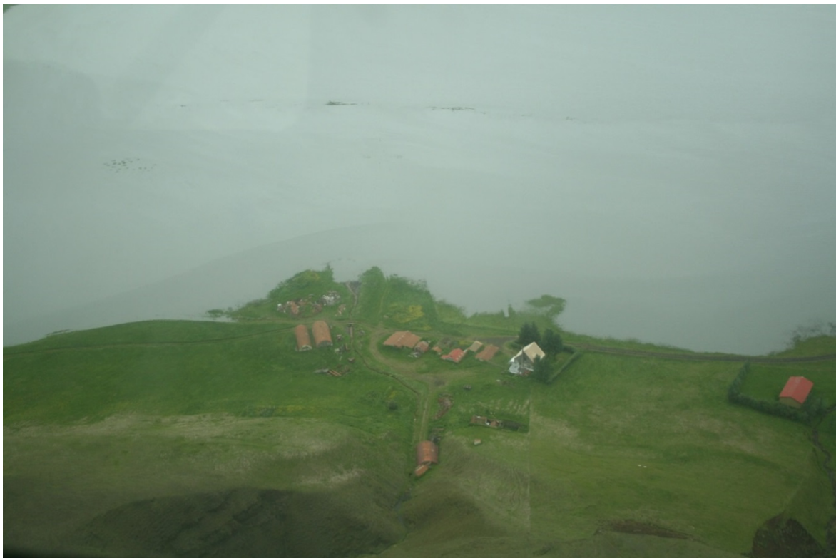
Mynd 9. Skaftárhlaup 29. júní 2010 kl. 11:32, við Svínadal. Vegurinn að bænum og svæði nærri mannvirkjum er víða undir vatni. Ljósmynd: Emmanuel Pagneux.
