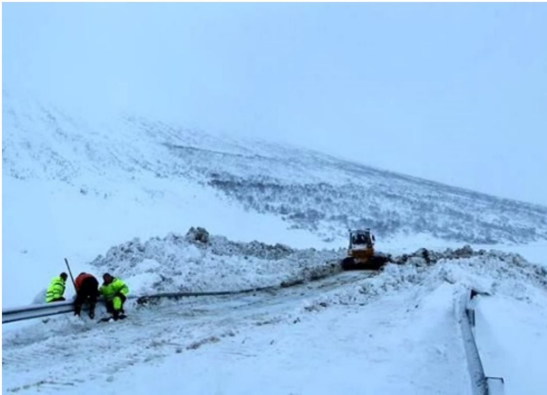
Mynd 16. Unnið að mokstri á flóðinu í Ljósavatnsskarði.
