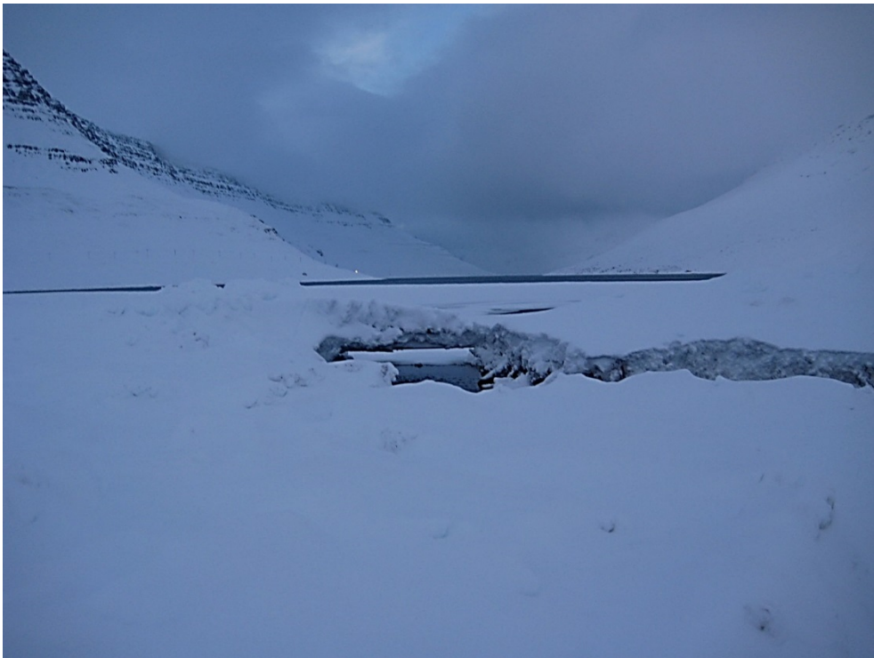
Mynd 25. Snjóflóðið fór yfir hluta nýja vegarins og brúna sem þar er.
